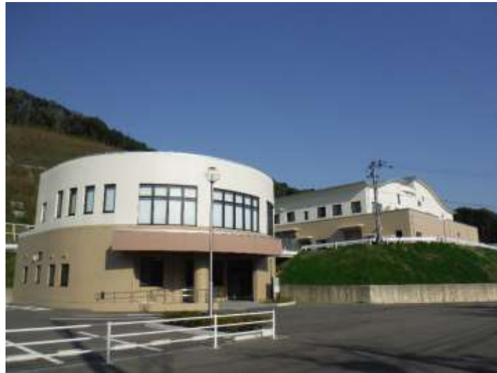
■西海市汚泥再生処理センター
