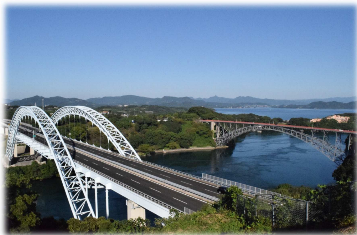
左：第2西海橋 右：令和2年12月 国の重要文化財に指定された西海橋
