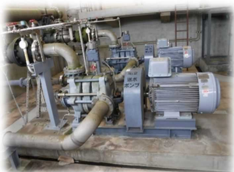
送水ポンプ (2号)
