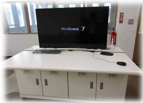
監視装置（管理本館）
