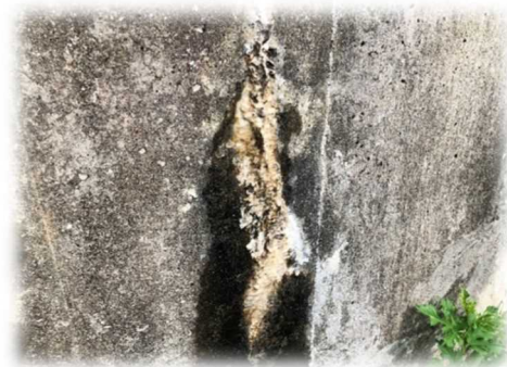
配水池 (漏水状況)
