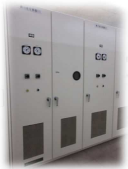
受変電設備（管理本館）
