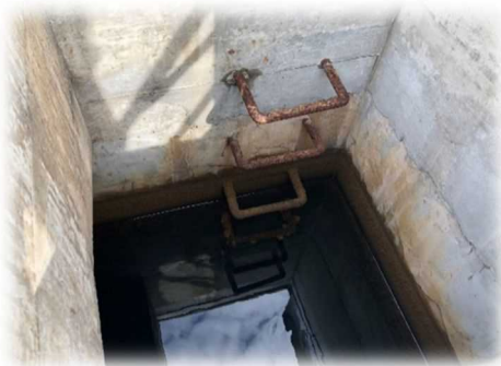
配水池 (開口部)
