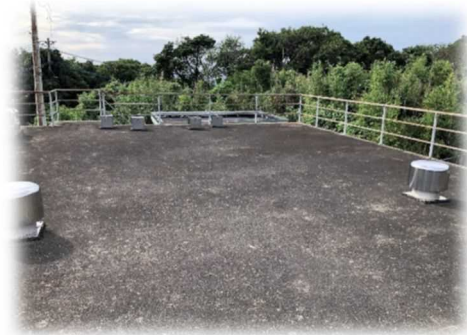
配水池 (スラブ上)
