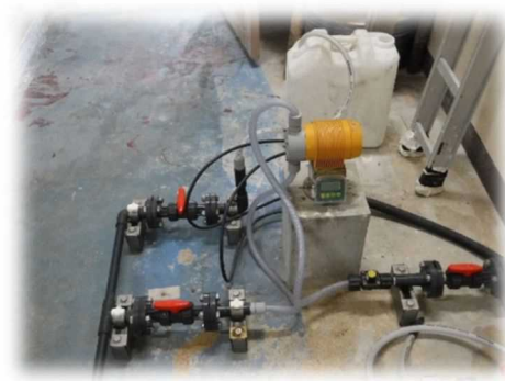
PAC注入設備
