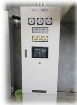
運転操作設備（管理本館）
