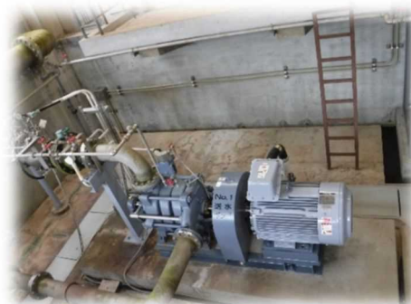
送水ポンプ (1号)
