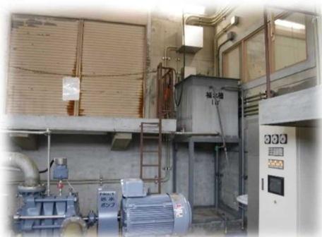
送水ポンプ室
