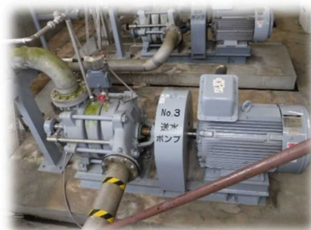
送水ポンプ (3号)
