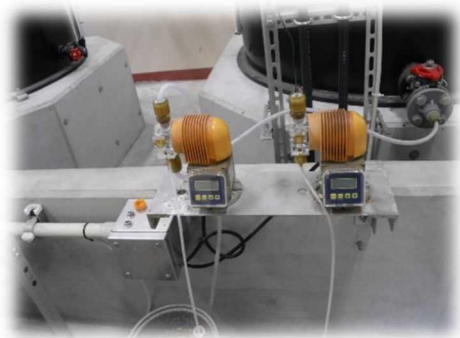
次亜注入設備
