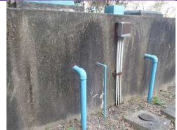
羽出川配水池
