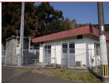
平山第2送水ポンプ所
