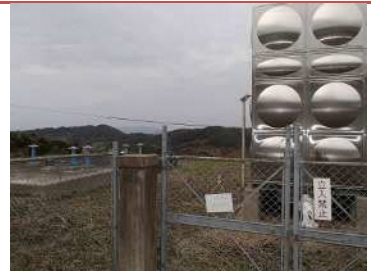
上岳第二配水池
