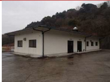
南部地区浄水場
