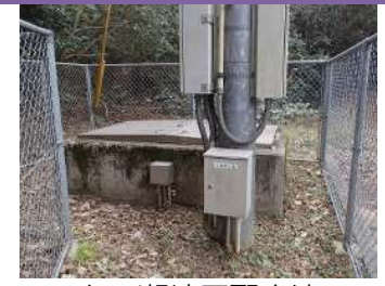
上ノ瀬地区配水池
