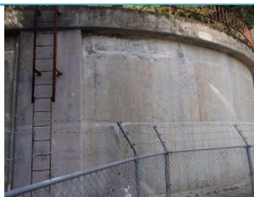
奥ノ谷配水池
