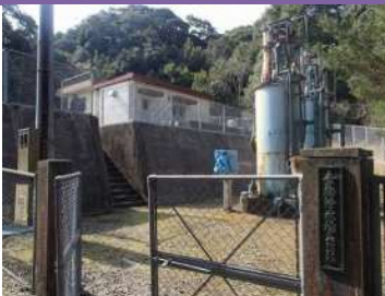
幸物地区浄水場（1）
