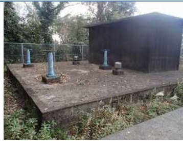
横瀬西配水池
