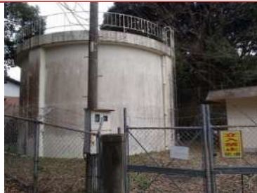
上岳第一配水池
