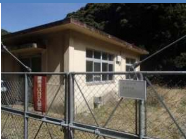
東部地区浄水場（1）
