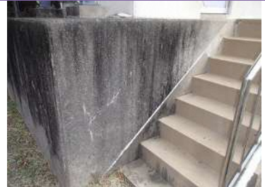
白樫地区配水槽
