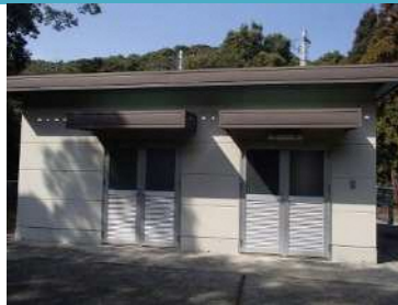
奥ノ谷送水施設（１）
