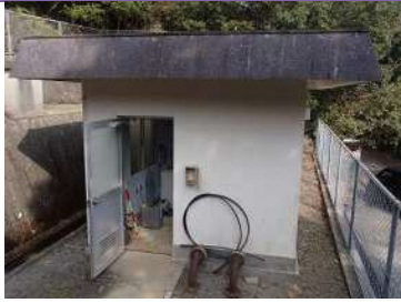
河通地区浄水施設（1）
