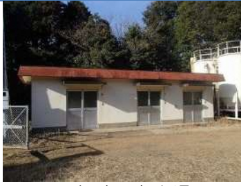
西部地区浄水場
