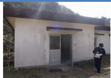
東部地区送水ポンプ所
