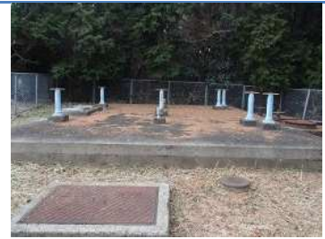
横瀬東配水池
