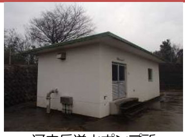
河内岳送水ポンプ所
