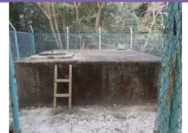
奉還地区配水槽
