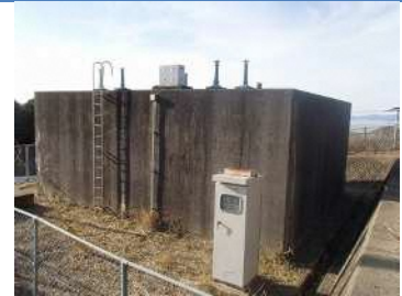
太田和配水池
