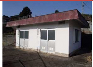
平山第1送水ポンプ所
