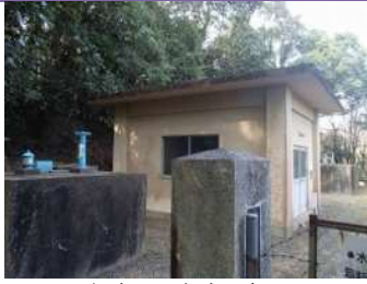
大瀬戸中部地区 浄水施設（1）
