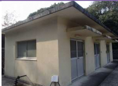
小松地区浄水施設
