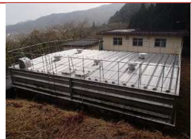
第2平原配水池
