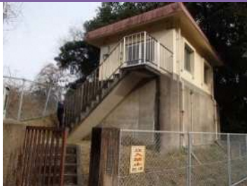
多以良浄水場（1）
