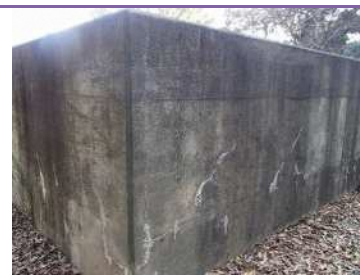
団地配水池 (瀬戸高部配水池)
