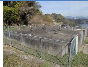
川内第一配水池
