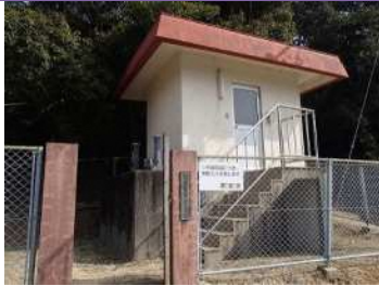
白樫地区浄水施設（1）
