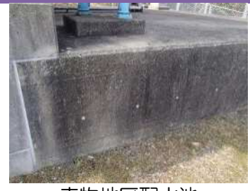
幸物地区配水池
