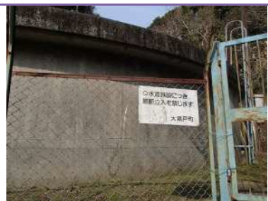
茅場第2配水池
