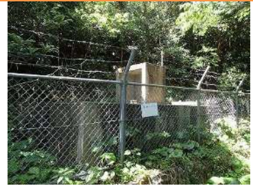
南風泊配水池
