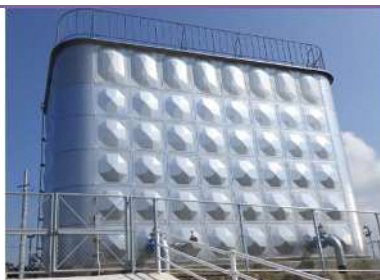
高校配水池（瀬戸配水池）
