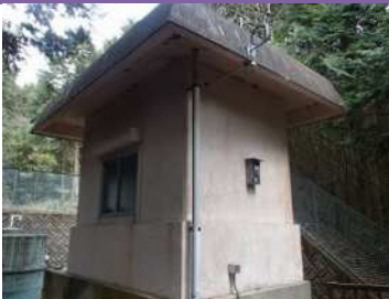
藤原地区浄水施設（1）
