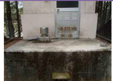
藤原地区配水槽
