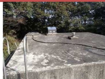
川山木場配水槽
