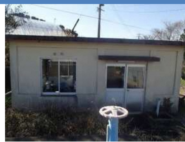
第二送水ポンプ所
