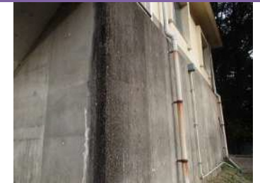
多以良配水池
