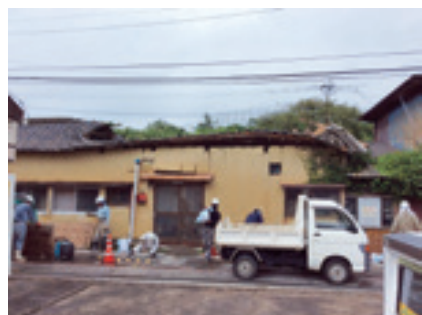
崎戸町にある老朽危険空き家
