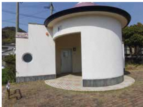
多目的トイレ（大瀬戸町 白浜）
