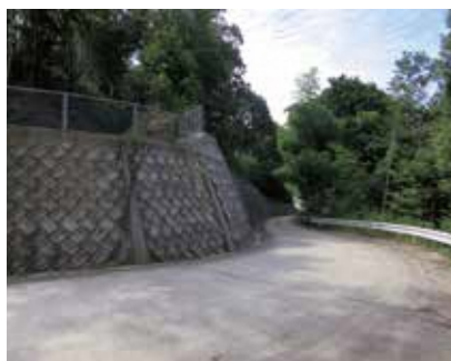
検証が行われている進入路
