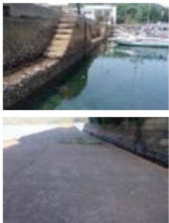
長年の浸食で劣化し、沈下し、亀裂が生じて危険な護岸階段 いる港湾施設
