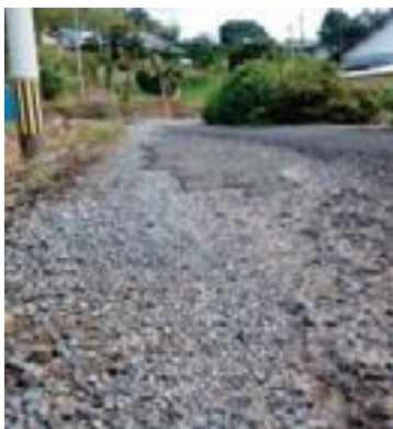
路面が著しく傷んでアスファルト下の碎石等が見られる道路(西海町水浦郷内)
