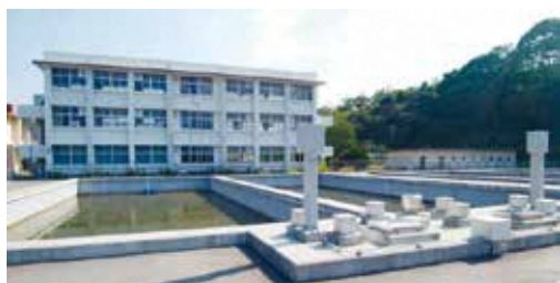
中浦浄水場 (西海町)
