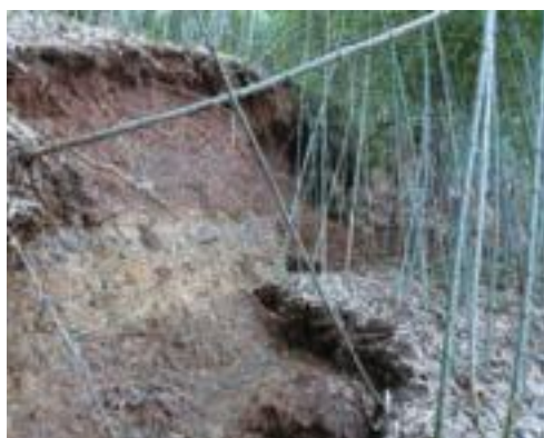
8月末の豪雨により崩壊した市内のため池(国道202号線沿い)
