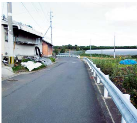
改良工事が待たれる市道横道汐見線
