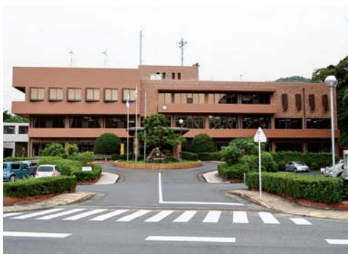
西海市役所本庁舎
