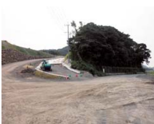
太田和ごみ処理施設進入道路工事
