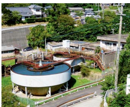
大島上水道施設
