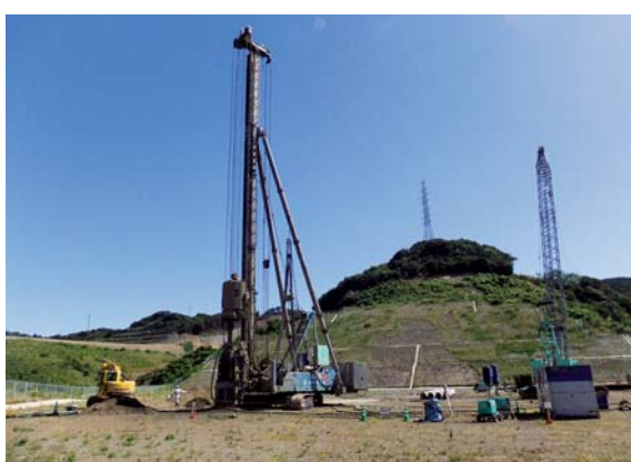
ゴミ処理施設建設に係るくい打ち工事
