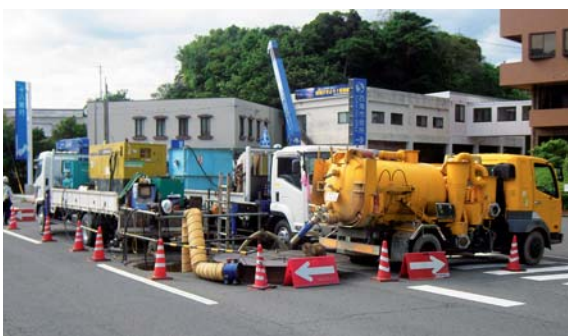
着々と進む下水道整備工事
