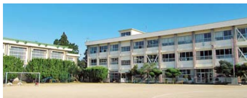
合併処理浄化槽未整備の西海東小学校
