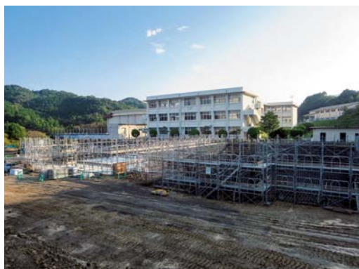
建設中の浄水場（旧西海南中学校）
