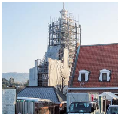
現在、4月のオープンに向けて改修工事 中の旧長崎オランダ村施設
