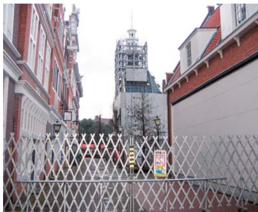
改修工事中の旧長崎オランダ村施設
