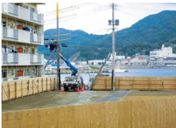
大瀬戸地区焼島漁民団地解体跡地
