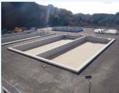
西海南中学校跡地に建設中の浄水場
