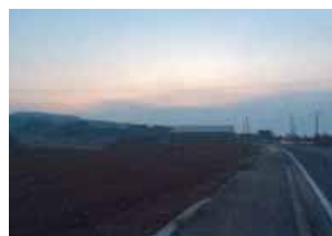
通学路外灯設置が求められる市道（写真は米海軍LCAC基地近くの西海町丸田地区）
