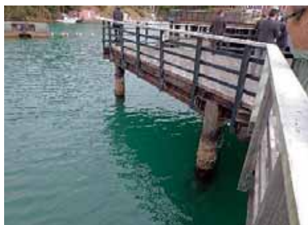
海面に打ち込まれた基礎支柱
