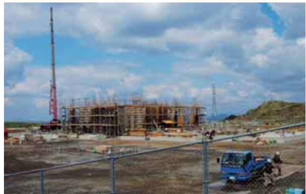
建設工事中西海市エネルギー回収推進施設 (西海町太田和郷)
