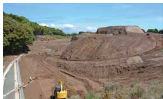
造成工事中の工業団地 (西彼町風早郷)
