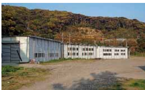
西海市マテリアルリサイクル推進施設の建設予定地である大島クリーンセンター
