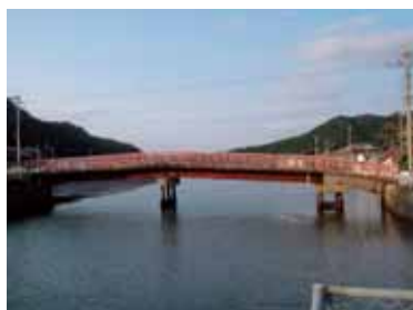
南串橋 (西海町)
