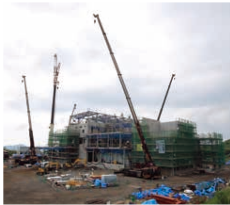
建設中の西海市エネルギー回収推進施設(ごみ処理施設)(西海町)
