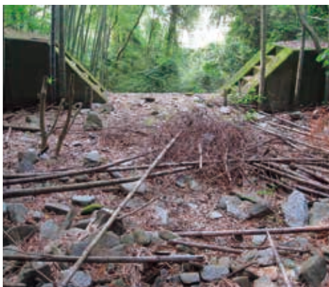
満砂状態になった砂防ダム(大瀬戸町雪浦)
