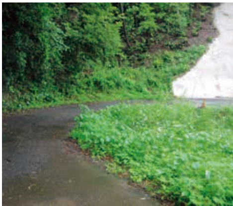
未整備区間である西彼町河内岳2号線
