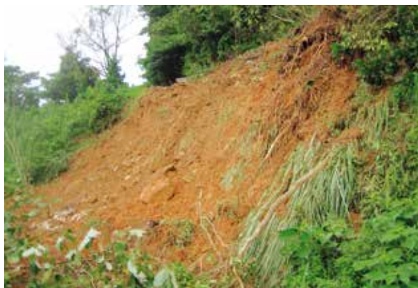
豪雨により崩壊した畑地(西彼町大串郷河内岳)
