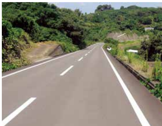
交通事故が発生した市道(西海町横瀬郷)
