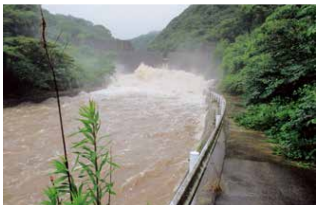
7月3日豪雨時の河通川砂防ダム付近
