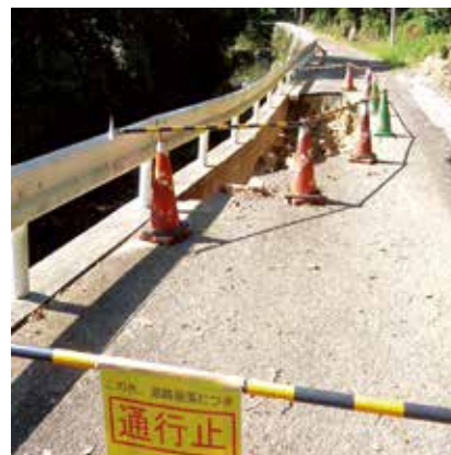
大雨の被害を受けた市道道目木線(大瀬戸町)
