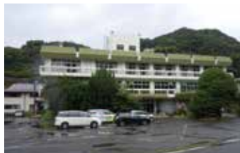
解体される予定の旧七ツ釜鍾乳洞観光ホテル本館
