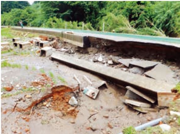
豪雨により破損した水路(大瀬戸町雪浦上郷)
