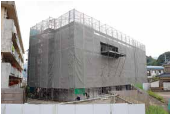
建設中の焼島単独住宅
