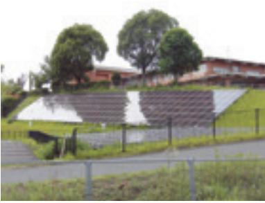
農村環境改善センターの太陽光発電施設
