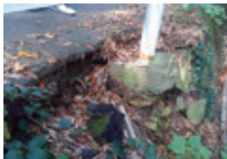
路肩が深くえぐられガードレール支柱が宙ぶらりんの箇所。下は住宅地がある。市道伊ノ浦線(西彼町)
