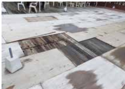
改修が必要とされたポートホール長崎の海上デッキの一部
