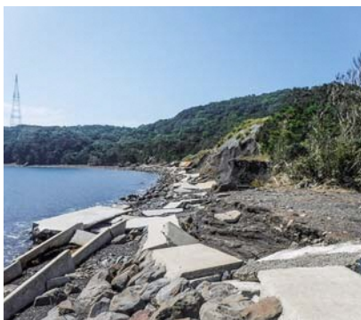
台風などによる松島西泊地区の被害 (大瀬戸町)
