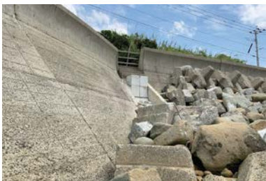
白浜高麗パ工建設海岸（大島町）
