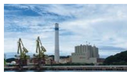
電源開発松島火力発電所
