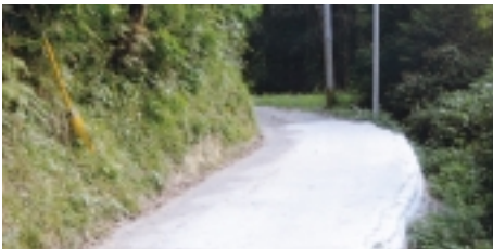
災害道路復旧状況
