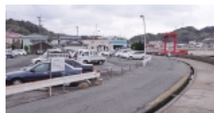
国道202号バイパス、建設予定に伴う移転予定地の市営駐車場と待合所
