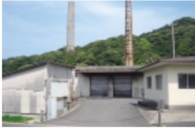
使用停止中の焼却施設
