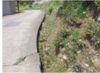
改修待ちの側溝
