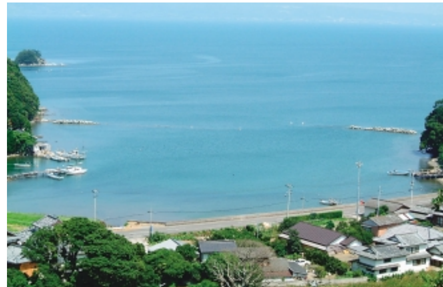
こわれている消波堤（西彼町）
