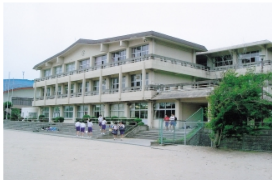
耐震改修予定の大瀬戸中学校
