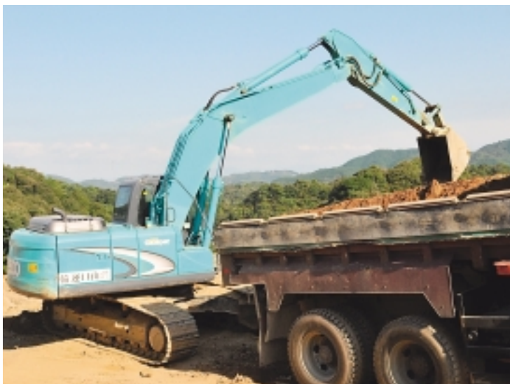
建設作業現場
