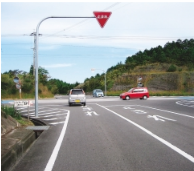
改修が急がれる交差点
