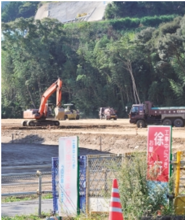
工事中の高規格道路仮称大串インター
