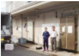
老朽化している大瀬戸漁協の冷凍庫
