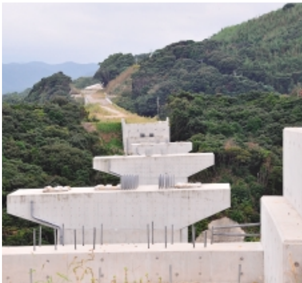
高規格道路の橋脚部分（小迎から八木原をのぞむ）
