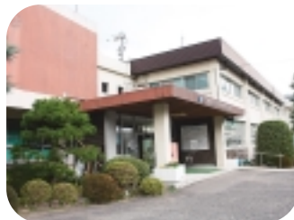
西彼総合支所（築43年）
