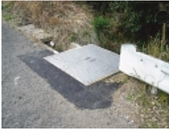
市道柚子川線側溝整備工事
