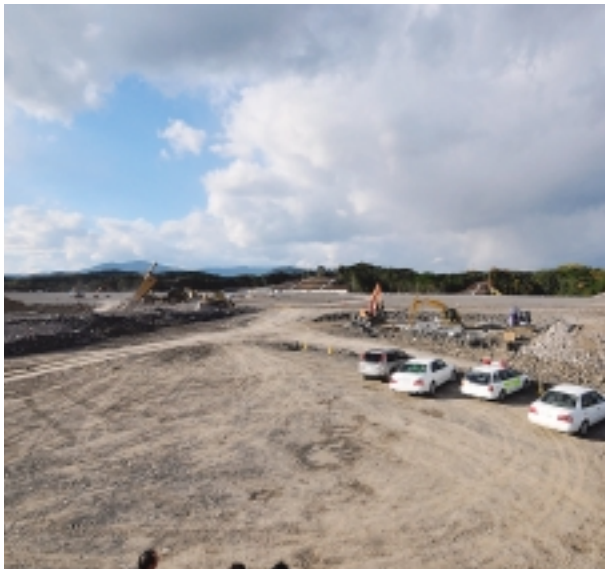
波佐見町の工業用地造成地
