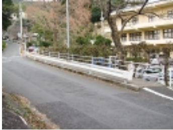
市道榎浦線防護柵修繕
