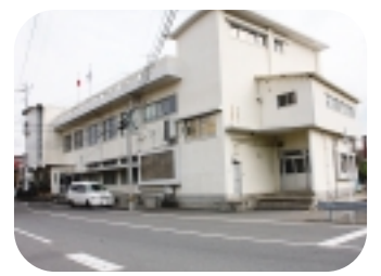
崎戸総合支所（築48年）
