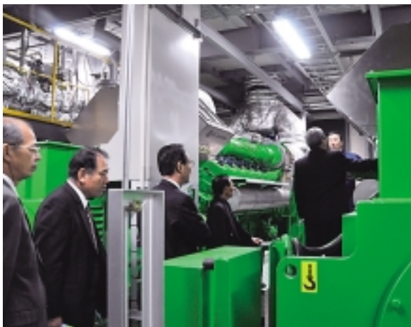
木質バイオマス発電所
