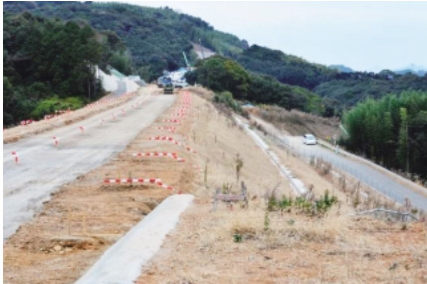
高規格道路工事
