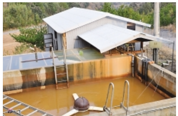
遊湯館の排水施設
