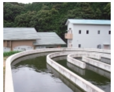
大串浄化センター汚泥処理棟
