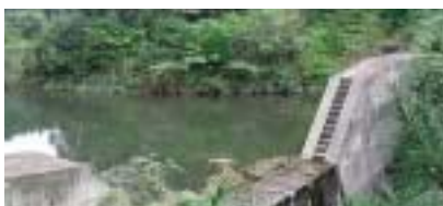
柚木川上流ミニダム
