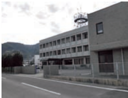
新たに建設水道部の事務がスタートする第四別館 (大瀬戸土木維持管理事務所)
