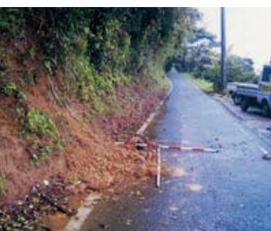
崎戸町新浦郷の法面崩壊場所
