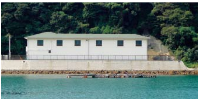
大島塩田漁業集落排水処理施設
