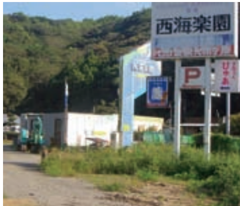
鍾乳洞入口付近の第1号井戸試掘現場
