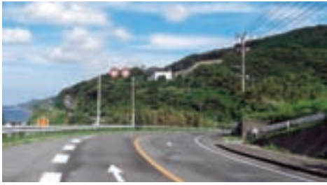
造成中の汚泥再生処理センター（大瀬戸町小松地区）
