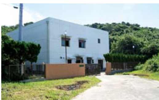
江島集落排水処理場
