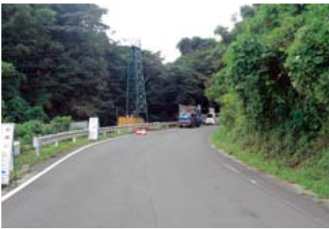
2本目のボーリング現場(西海町中浦北郷)
