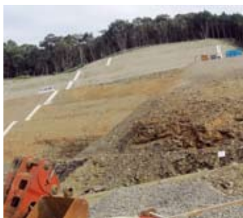
法面工事中（大瀬戸町）
