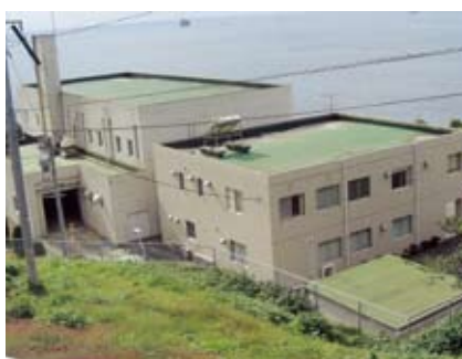
現在のし尿処理施設（この上側に新設される）
