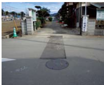
下水道管のルート変更地(病院建設予定地)
