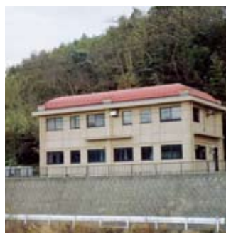
太田和地区農業集落排水施設(処理場)
