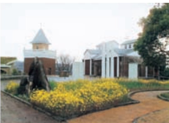
管理が検討される横瀬浦公園（西海町）
