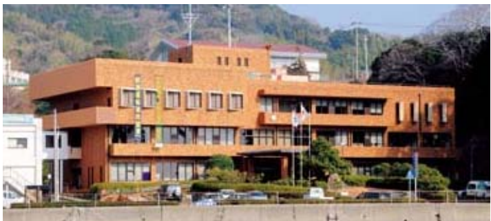
西海市役所本庁舎
