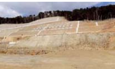
西海市汚泥再生処理センター造成現場(大瀬戸町)
