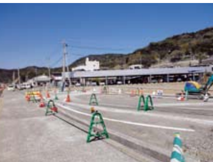
市営駐車場工事現場（大瀬戸町）
