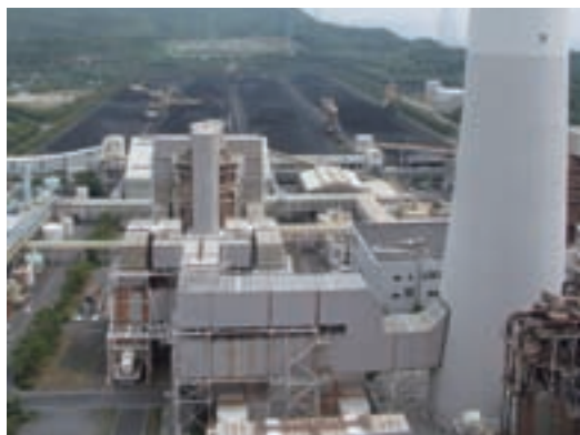
松島火力発電所
