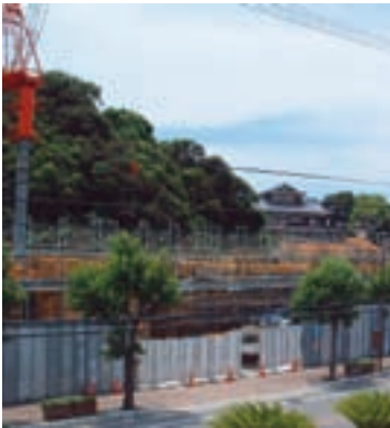
建設中の西海医療・福祉センター（大島町）
