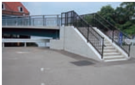
旧長崎オランダ村へ架けられた橋
