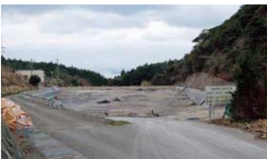
西海市大瀬戸最終処分場
