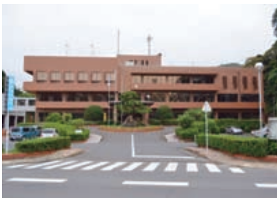
西海市役所本庁舎
