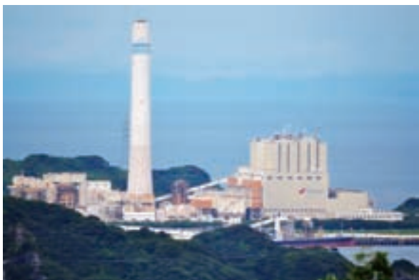
松島火力発電所
