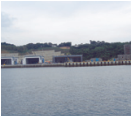
建設中のLCAC施設
