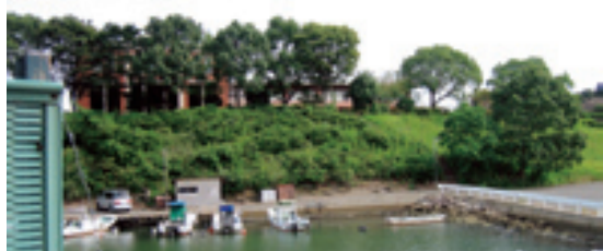
太陽光発電設置予定地（西彼農村環境改善センター 法面）
