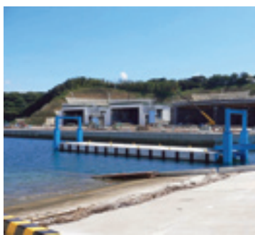
建設中の格納庫
