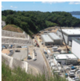
建設中のLCAC施設
