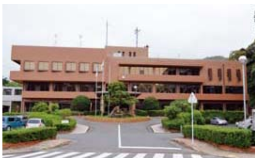
西海市役所本庁舎
