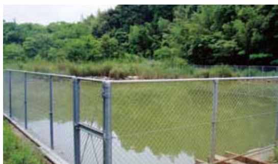
西彼保健福祉センターの排水調整池
