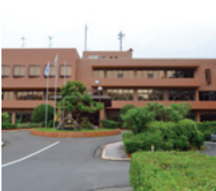
西海市役所本庁舎
