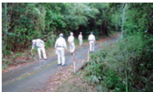
道路の破損が見られる（西彼町）
