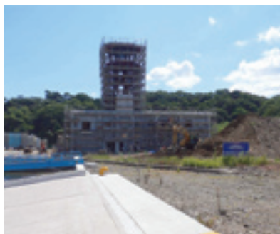
建設中の管理棟
