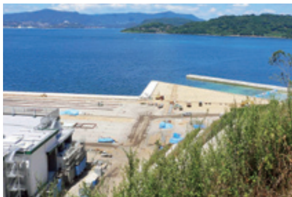
建設中のL C A C基地(西海町)
