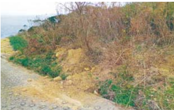
イノシシにより被害を受けた車道
