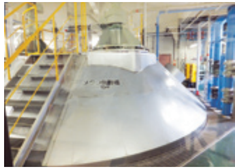
エコパーク21のメタン発酵槽
