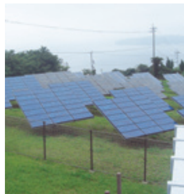
太陽光発電設備 (崎戸町)
