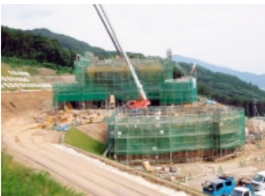
建設中の西海市汚泥再生処理センター（大瀬戸町）
