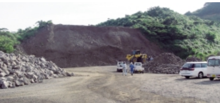
西海市エネルギー回収推進施設（ごみ処理場）敷地造成工事現場（西海町）
