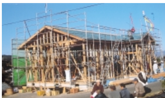
完成が間近な大串地区公民館（西彼町）
