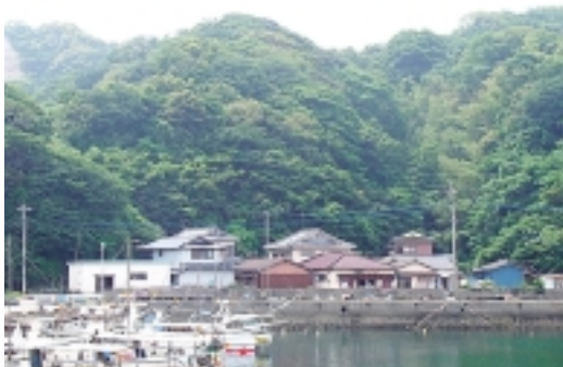
福島(1)地区急傾斜地対策事業
