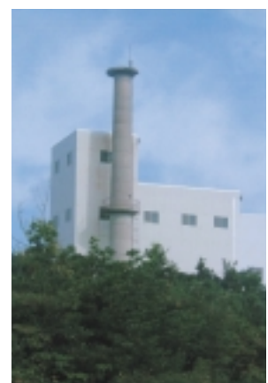
西海町クリーンセンター
