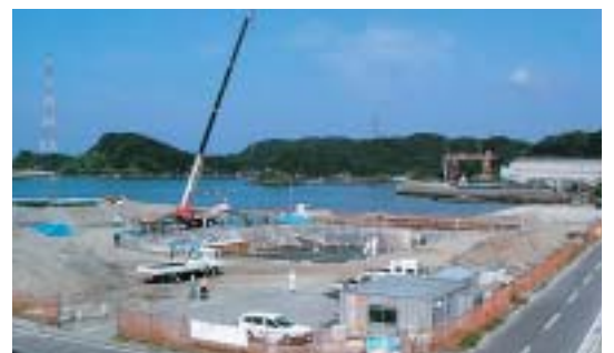
瀬戸地区浄化センター
