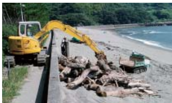
流木撤去作業状況
