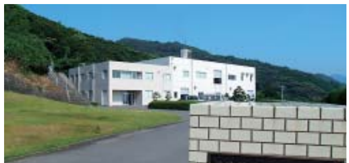
外海地区衛生施設組合相川処理場
