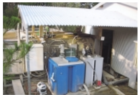
福祉センター遊湯館の浄化施設
