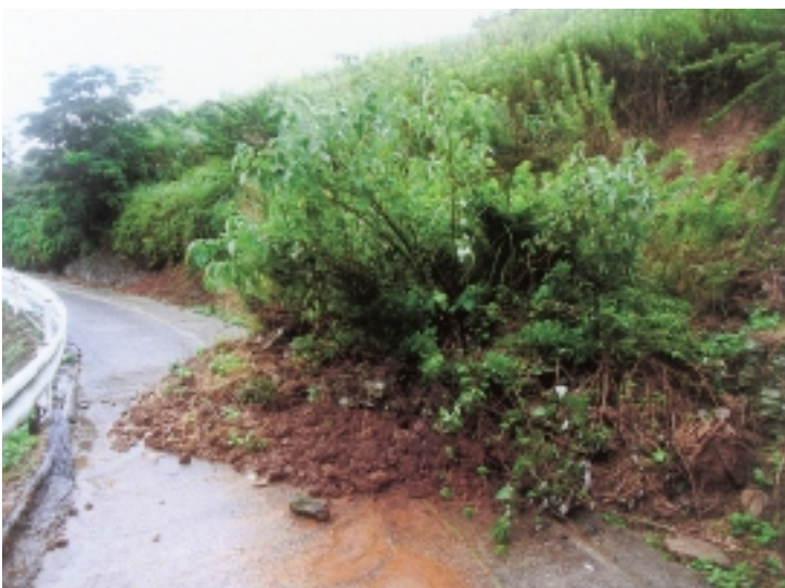
土砂崩れした西彼山中1号線
