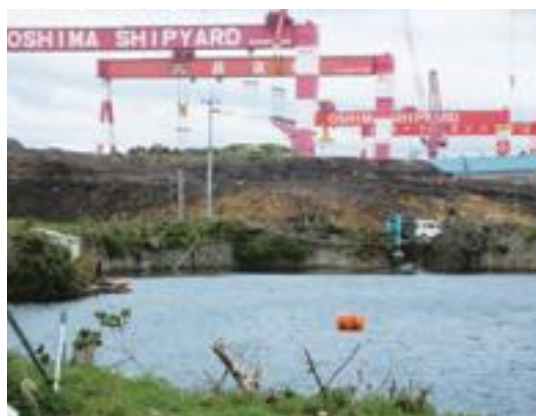
工事中の大島工業団地（大島町）
