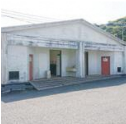
西彼中央運動場横の公衆トイレ
