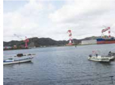
早期完成が待たれる肥前大島港埋立工事
