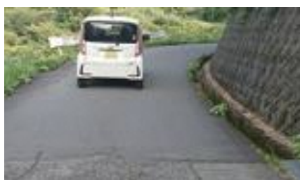
側溝蓋がない市道
