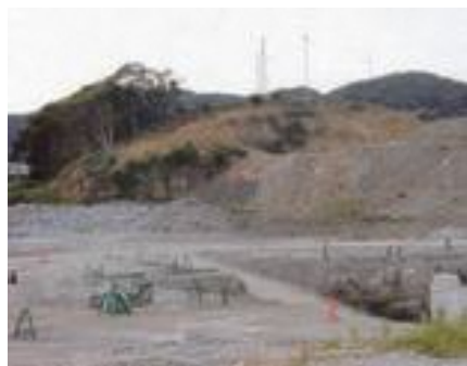
埋立用の切土が進む大島町真砂地区
