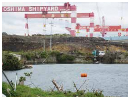
工事中の大島工業団地（大島町）
