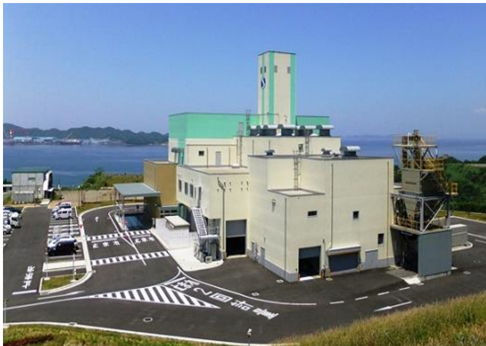
西海市炭化センター（平成27年7月稼動）
