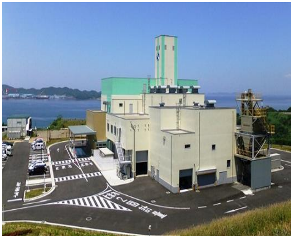
西海市炭化センター（平成27年7月稼動）
