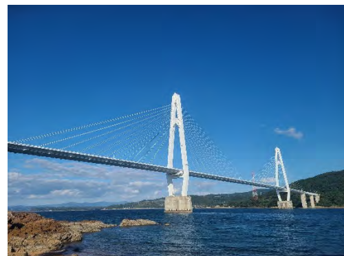
写真 2-6 大島大橋（現代）
