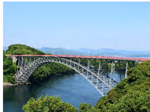
写真 2-8 西海橋 (国重要文化財)
