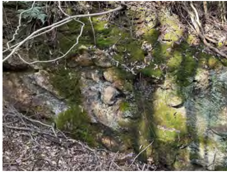
写真 5-14 コケの繁茂状況
