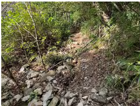
写真 5-32 見学路（崩落箇所）
