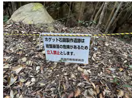
写真 5-4 見学路閉鎖状況②
