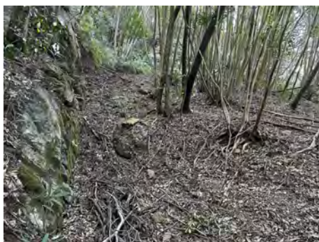
写真 5-28 土砂の堆積状況①
