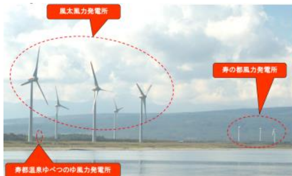
寿都町における風力発電所の様子
